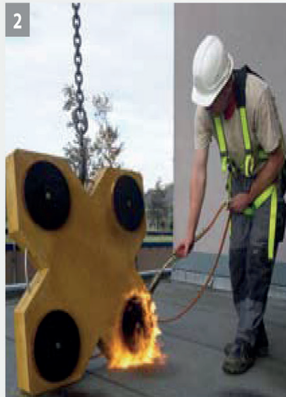
Erwärmen der Bitumen-Klebmatte
