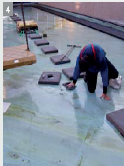
Reinigen des Untergrundes
