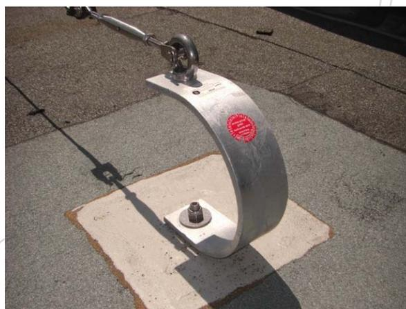
**Seilsicherungssystem Typ C**
