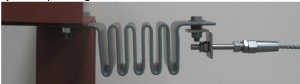
Foto 2 – Position von Mutter und Kontermutter an dem Befestigungsbeschlag
