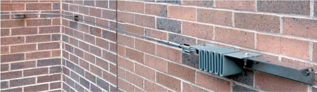
Foto 1 – Beschläge gibt es für die Montage an Ziegel- und Betonfassaden sowie auch für Stahlkonstruktionen
