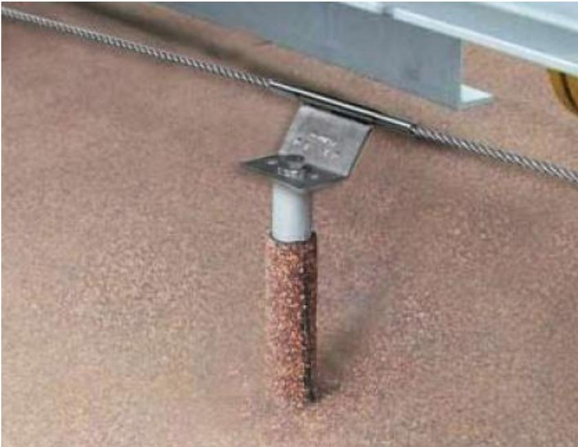
Abbildung 31 - KeeLine® an POSTANKA montiert
